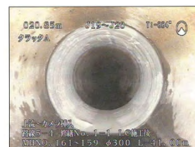
写真2 内面修繕を実施
