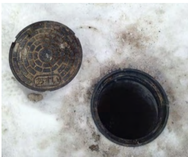
写真1 排水枡の蓋を開けた状態
