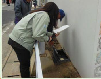
この日は合計5カ所の現場を回りました！設置されている量水器のメーターを確認したり、実際に水を流して下水に接続されているか確認を行います。
