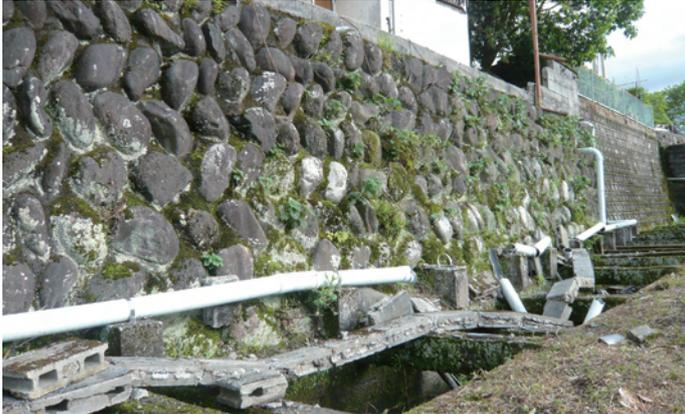
熊本県益城町におけるクイック配管（露出配管）の被害状況
