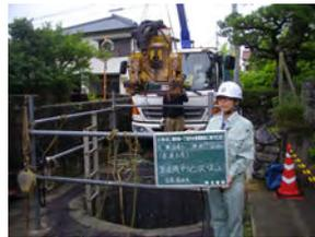
推進工法による工事風景「推進機据え付け状況」
