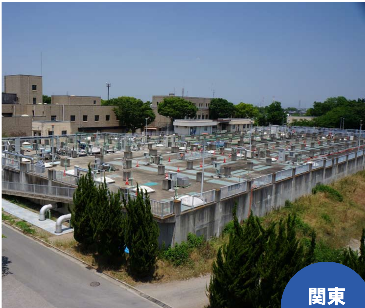
埼玉県利根川右岸流域下水道 小山川水循環センター（埼玉県本庄市）
