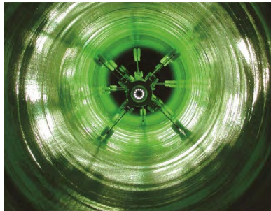
写真1 光硬化工法
