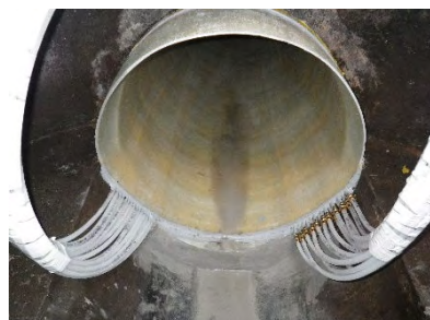
写真2 ヒートライナー工法
