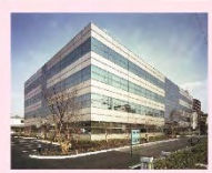
前澤工業株式会社 本社（埼玉県 川口市）
