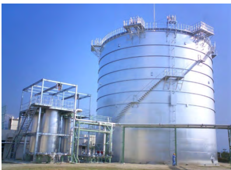
消化ガス貯留設備として国内シェアトップクラスの当社ドライシールガスホルダ
