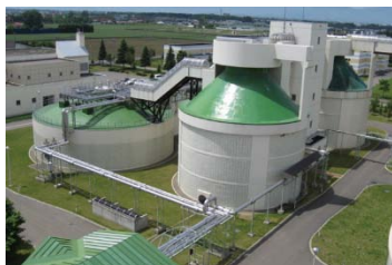
消化槽は嫌気条件下で有機物を分解します。分解されて発生したメタンガスは場内で燃料として使用しています。
