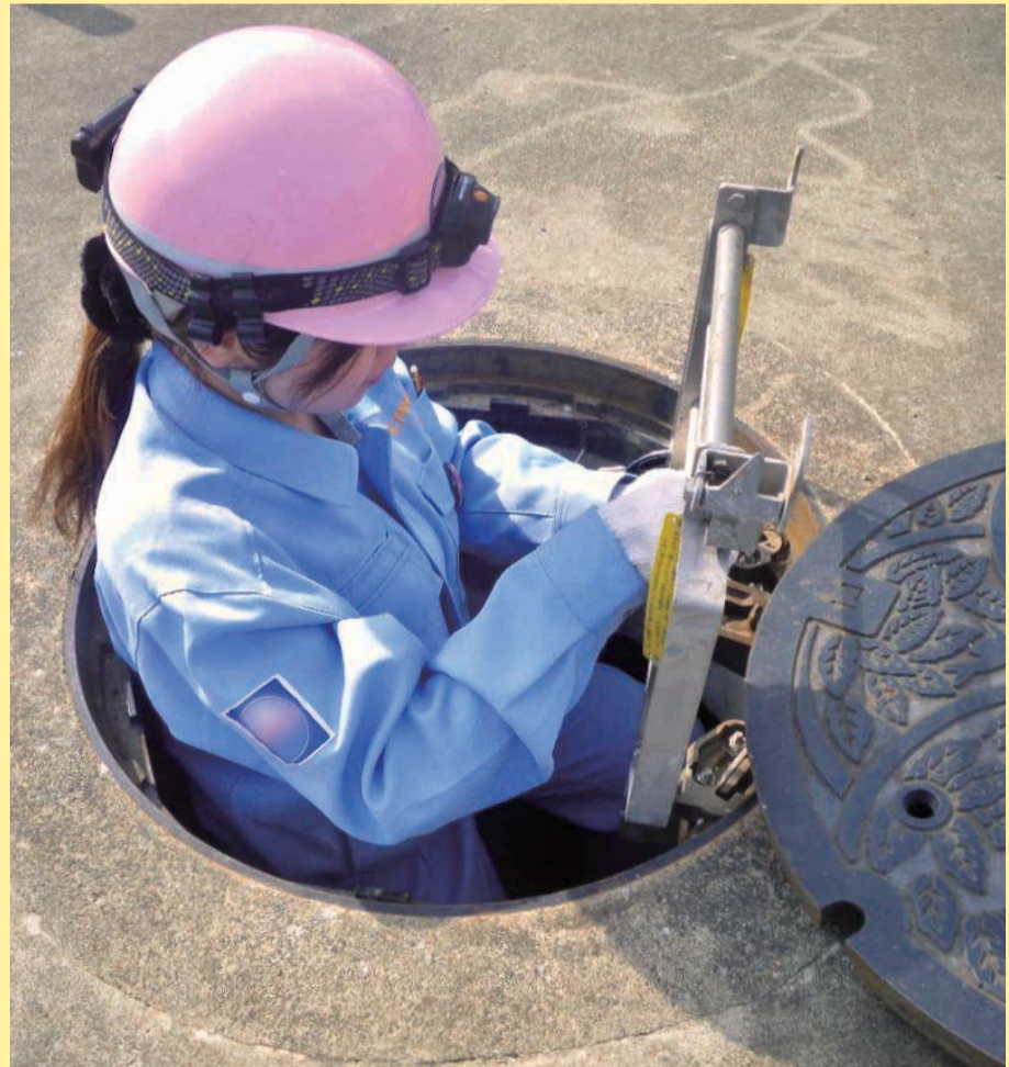
マンホールの中に入って、清掃や点検などをします。
