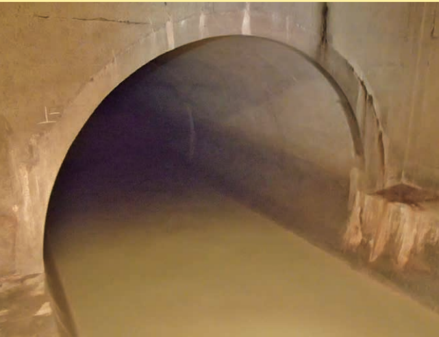
台所や風呂、トイレなどで使った水が流れている下水道管。
